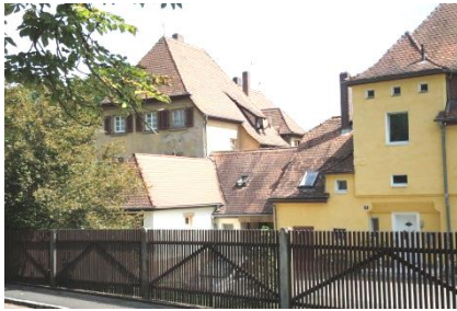
Abbildung 59: Wohnhäuser Hornschuchshausen (Baudenkmal) Quelle: Eigene Darstellung
